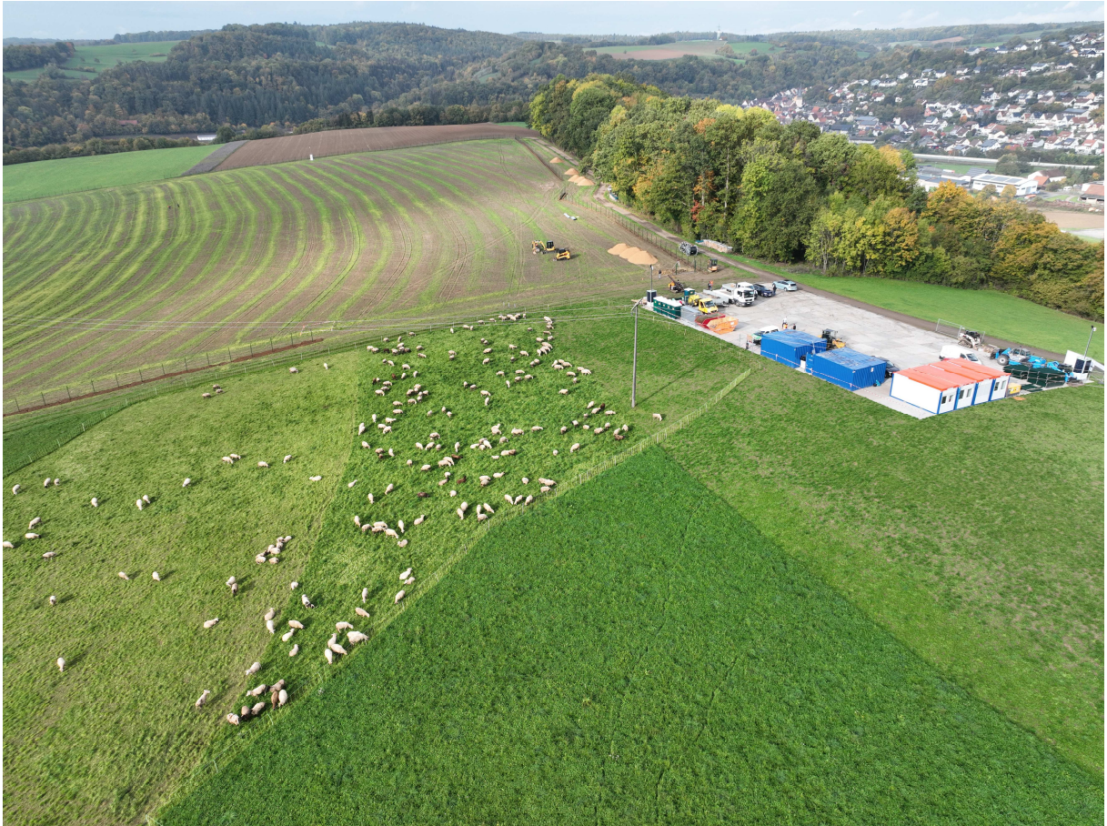
Auf dem Roigheimer Gewinn Ebene/Schafberg haben die Bauarbeiten für die neue PV-Freiflächenanlage begonnen.
